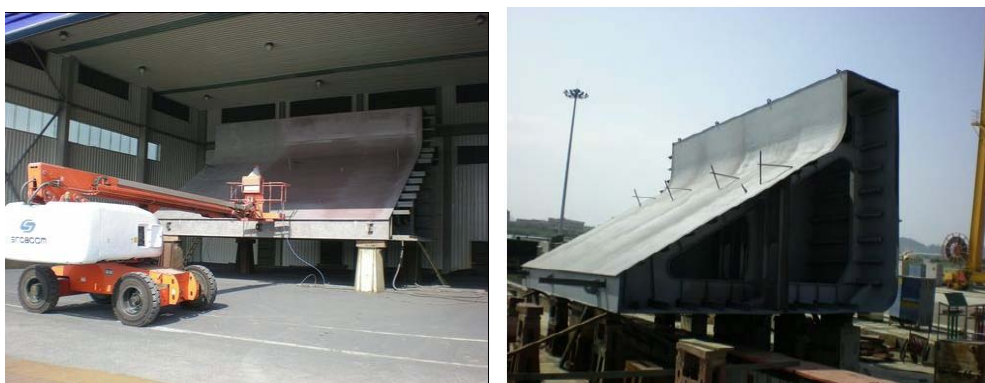
空舱分段喷涂纳米复合环氧底漆
