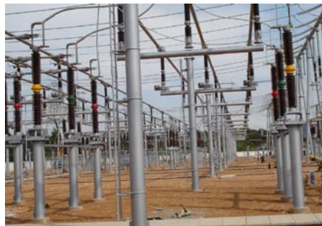
图 6 华中电网湖南电力 500kV 长沙变电站防腐工程
